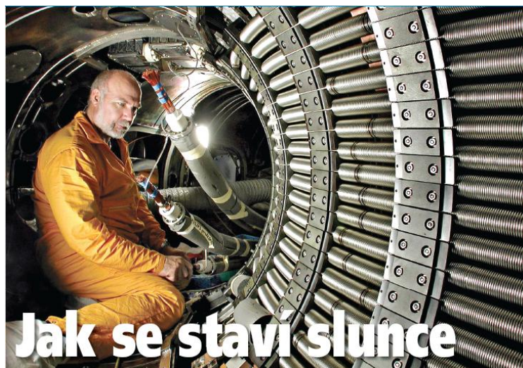
Obrázek 163: Výstavba tokamaku ITER
