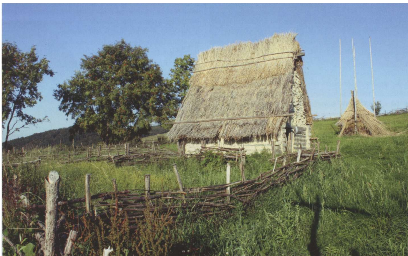
Hrázděná konstrukce - nepálené hliněné cihly (rekonstrukce Modrá)
