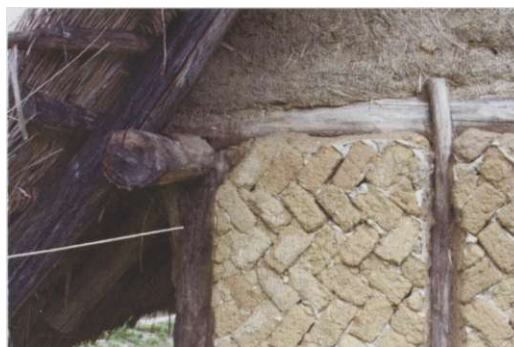
Hrázděná konstrukce - nepálené hliněné cihly (rekonstrukce Modrá)
