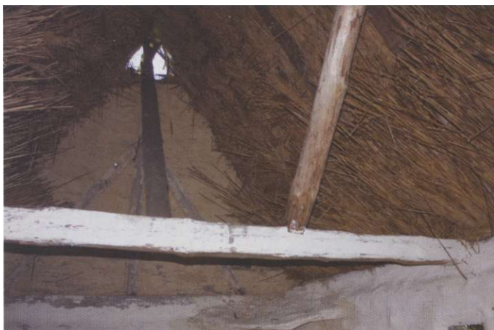
Dýmnik - otvor ve střeše nad ohništěm v rekonstruovaném srubu z 12. století
