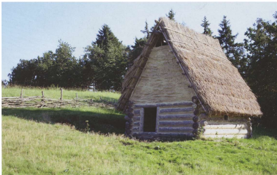
Vesnický Jednoprostorový dům - obydlí postavené technikou srubové konstrukce s trámy skládanými v rozích napříč. Rekonstrukce podoby z druhé poloviny 12. století ve Vítkově u Chrástavý
