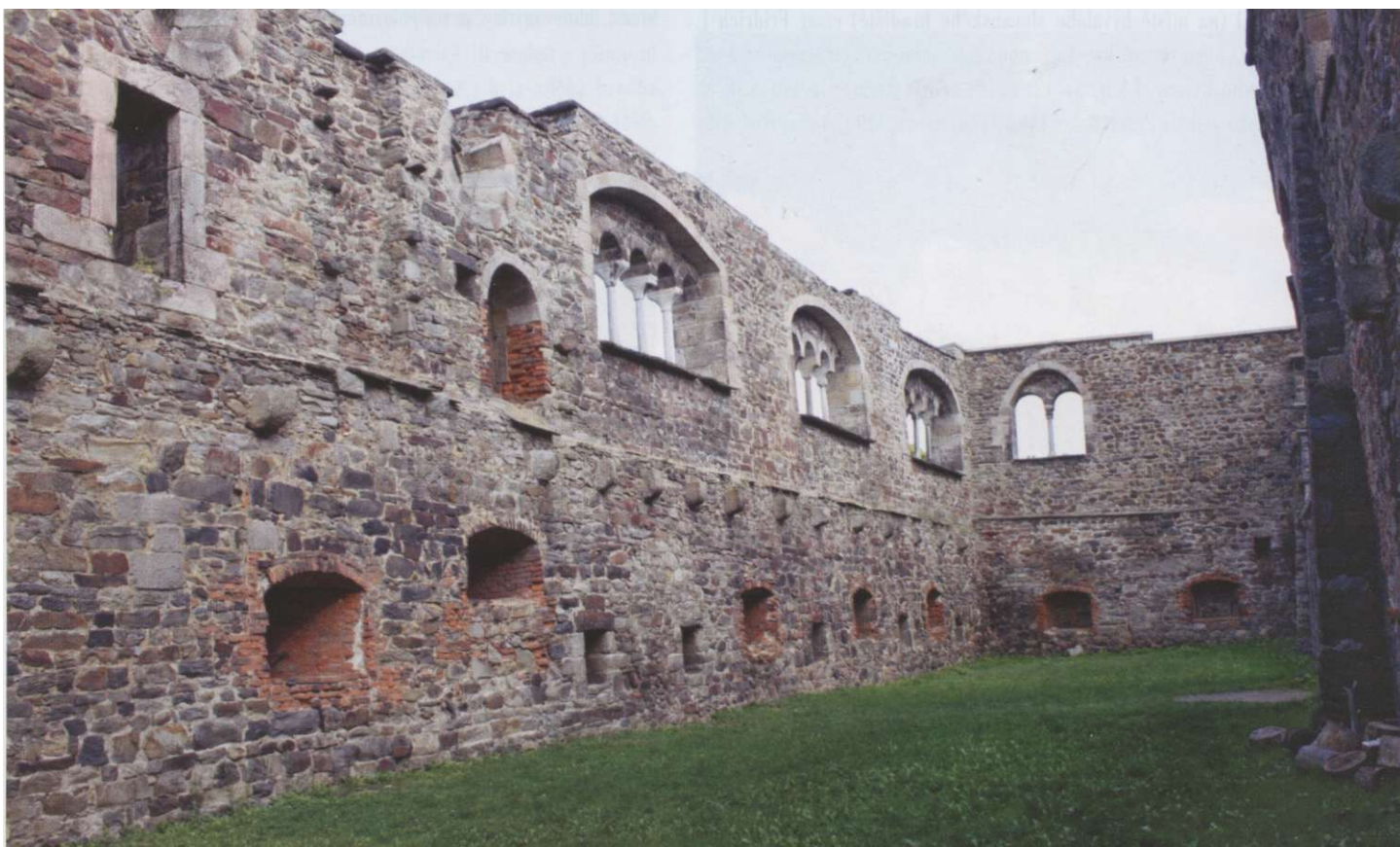
Vnitřek paláce - sdružená okna vymezují původní velký sál v 1. patře (ve zdi krakorce, které nesly podlahu)
