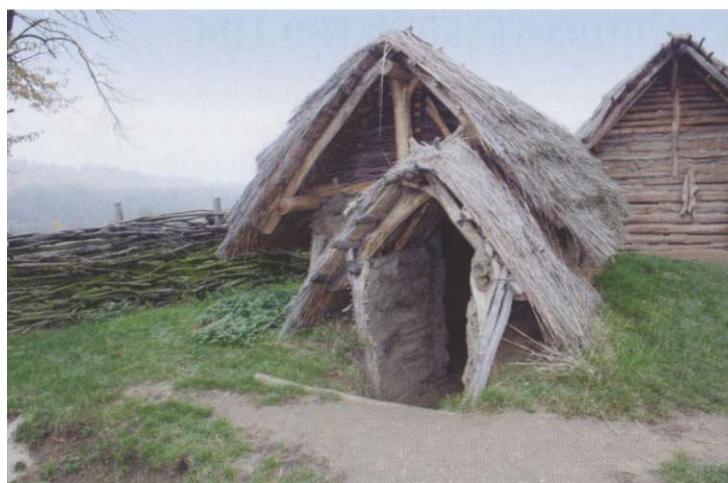
Velkomoravská zemnice - obydlí rybáře, stěny z proutěného výpletu umazaného hlinou (rekonstrukce Modrá)
