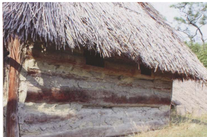
Okenní otvory - rekonstrukce raně středověkého srubu
