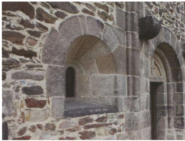
Cheb - portál hradní kaple
