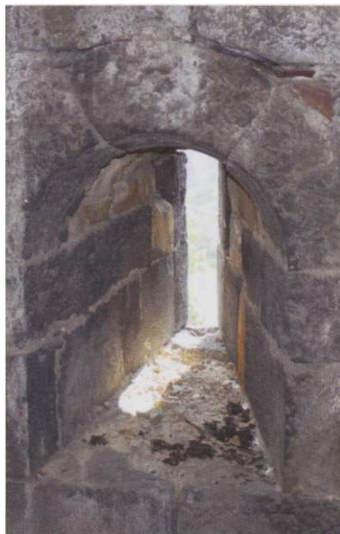
Cheb - střílna v patře Černé věže
