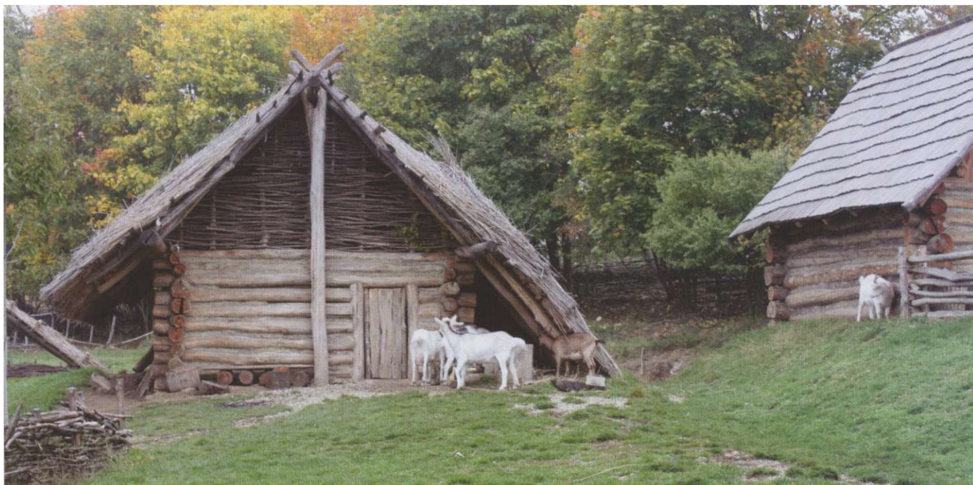
Roubený velkomoravský dům - robustní srub (rekonstrukce Modrá)
