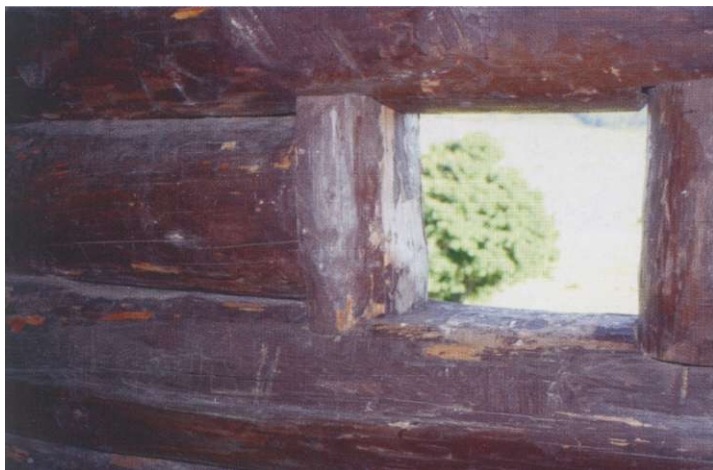
Okenní otvory - byly horizontální a zhotovovaly se jednoduchou technikou na šířku trámu
