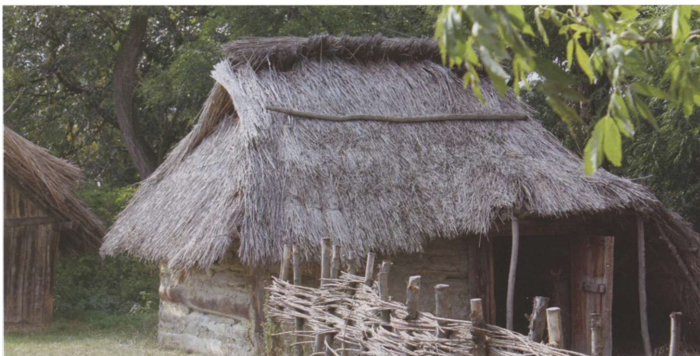
Raně středověký roubený dům - obydlí postavené technikou drážkové konstrukce nad mělkým zahloubením (rekonstrukce podle archeologických nálezů z 9. století v Březnu u Loun)
