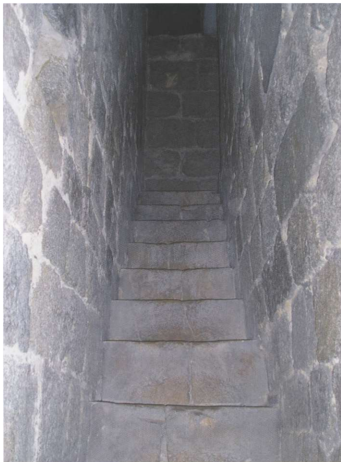
Týnec nad Sázavou - schodiště v síle zdi věžovitého paláce
