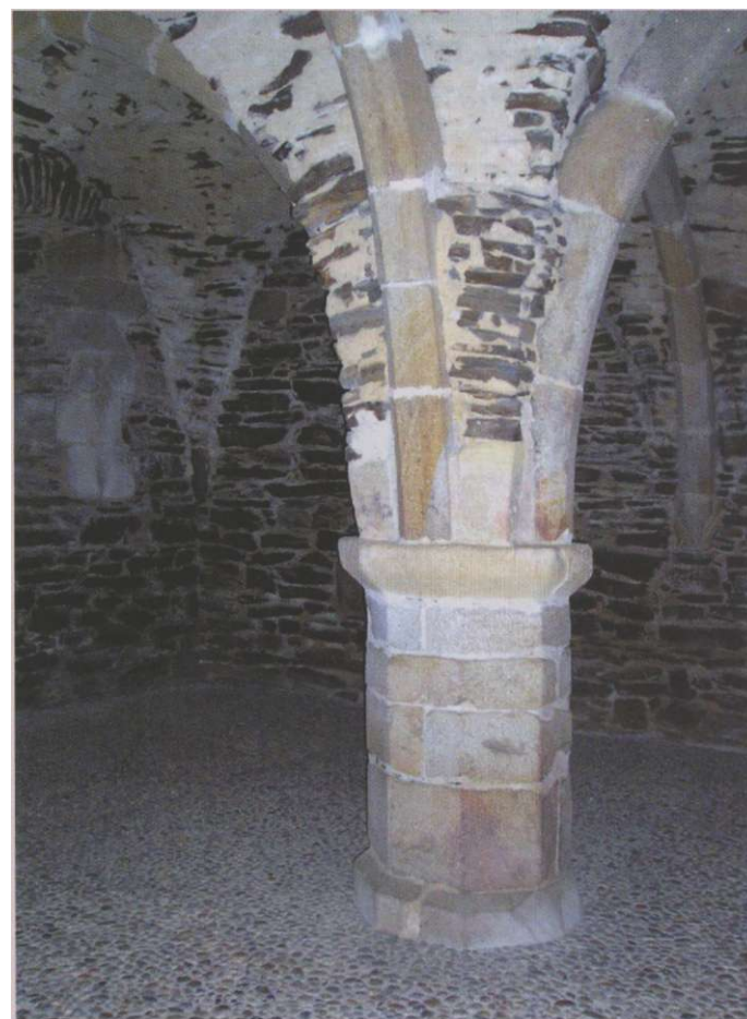
Horšovský Týn - klenuté podzemní sklepení
