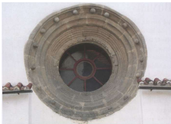
Strakonice - okno nad vchodem do kapitulní síně johanitské komendy, 2. čtvrtina 13. století
