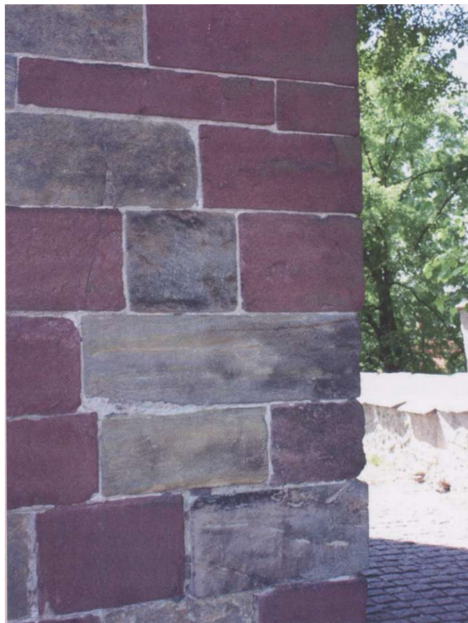
Románské zdivo - kostel Zvěstování Panny Marie (původně sv. Petra a Pavla) v Plaňanech (kolem roku 1200)
