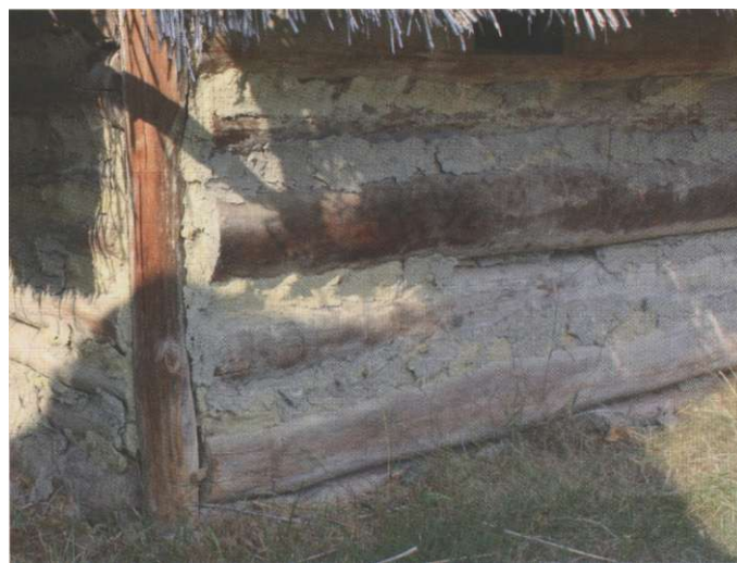
Drážková konstrukce dřevěného domu - rekonstrukce v Brezně u Loun
