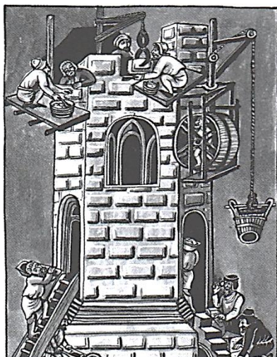
Stavba babylonské věže – použití kola k pohonu kladky, iluminace z Bible Václava IV., konec 14. století
