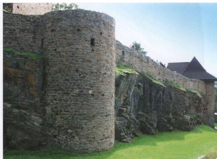
Velhartice - hradba s příkopem vytesaným do skály, 14. století
