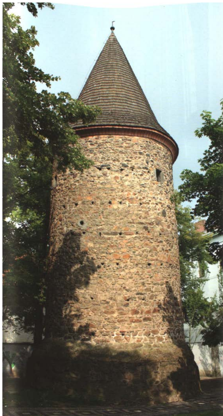
Klatovy – okrouhlá věž vnitřního městského opevnění, přelom 14. a 15. století
