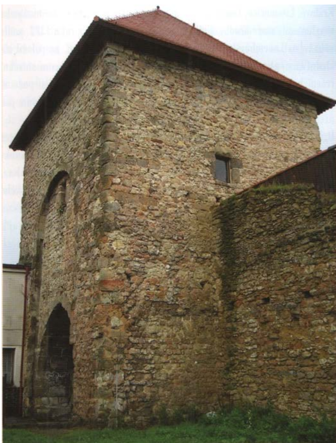
Bělá pod Bezdězem – Česká brána, mohutná hranolová věž s opevněním, 1. polovina 14. století
