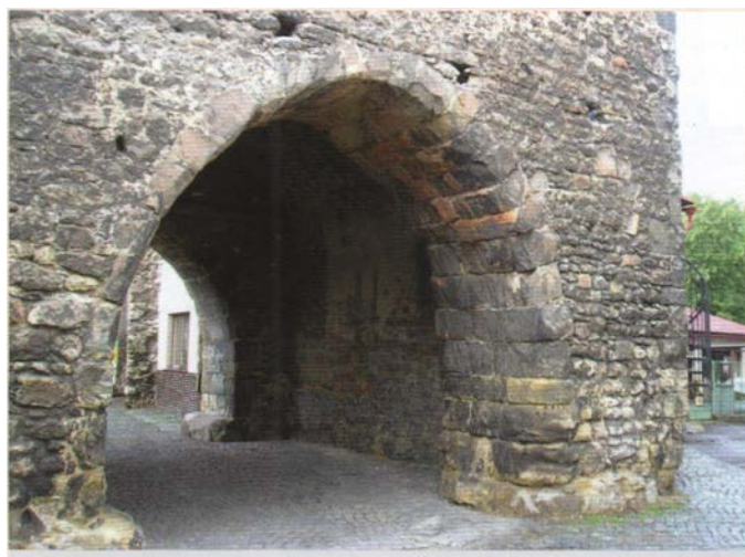
Bělá pod Bezdězem - valený klenutý průjezd Českou branou, 1. polovina 14. století
