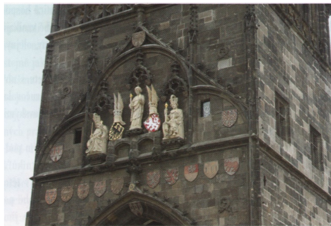
Praha - průčelí Staroměstské mostecké věže
