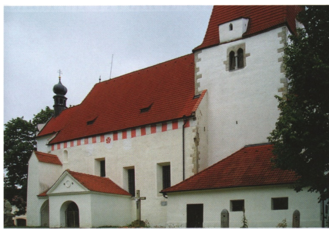
Horní Stropnice - kostel sv. Mikulase, po roce 1486
