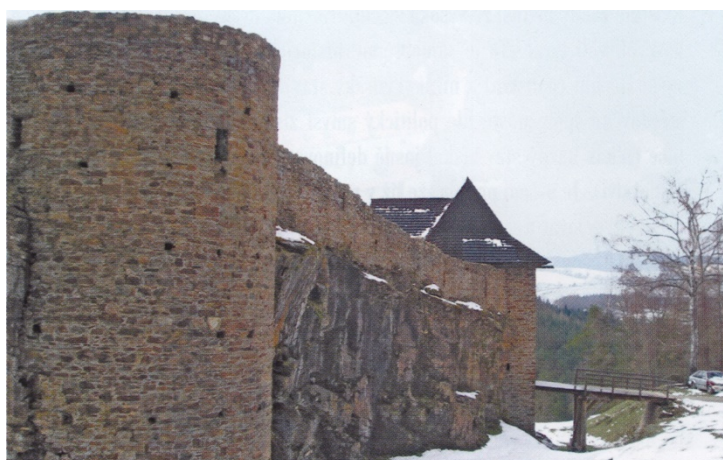
Velhartice - hlavní hradební zeď s příkopem
