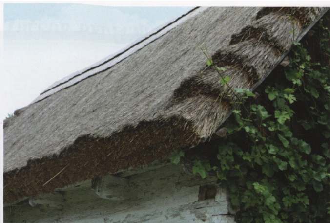
Střeška krytá vázanou slámou - skanzen Přerov nad Labem
